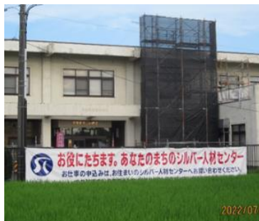
👉 新事務所（旧市下水道事務所）
