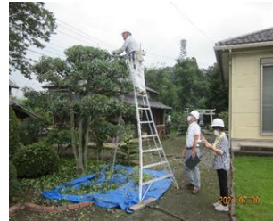
👉 安全パトロールの様子
